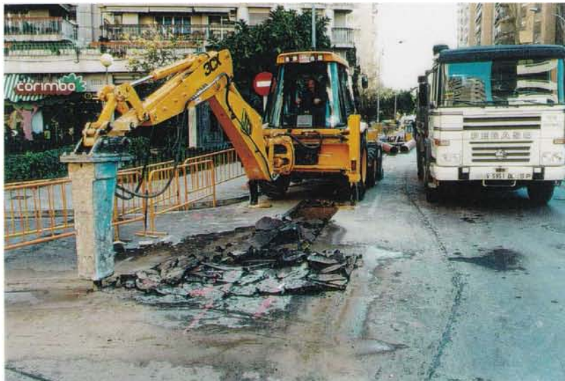
DEMOLICIÓN MECÁNICA DE PAVIMENTO ASFALTICO
