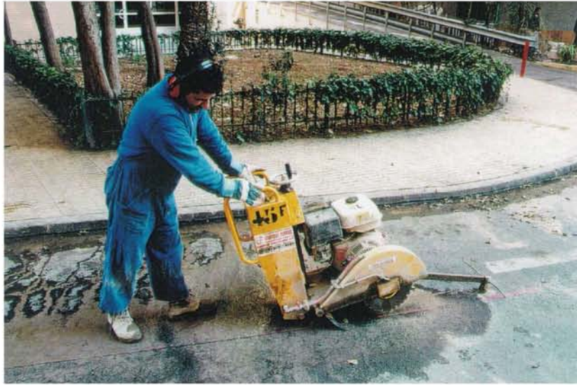
CORTE DEL PAVIMENTO ASFALTICO
